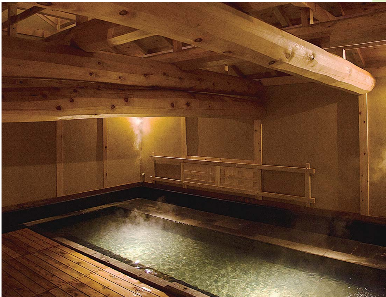
伝統工法で復元された「大湯」。内壁は、茶室の炉壇をつくる土を京都から取り寄せて造った
